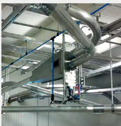
De 6" (152mm) Diversora de tubo flexible que maneje granos de café
