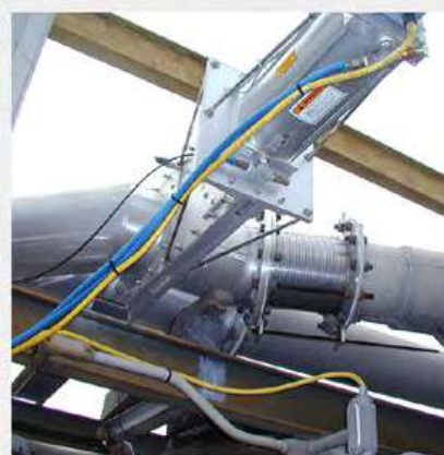
Válvula de orificio Quantum de 12" (305 mm) para el manejo de la resina de polietileno en polvo
