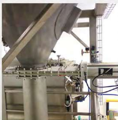
10 "(254 mm) Válvula de Orificio Quantum para el manejo de cemento en polvo
