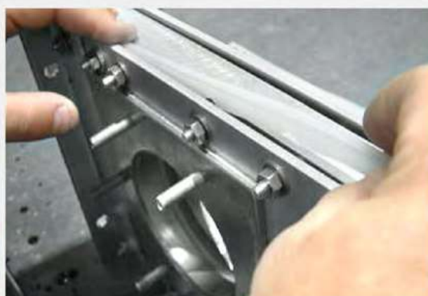
Desmontaje de empaque del sello de ajuste mientras que la válvula está en línea
