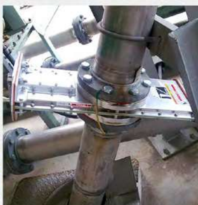
Válvula de orificio Quantum de manivela con una brida ANSI
